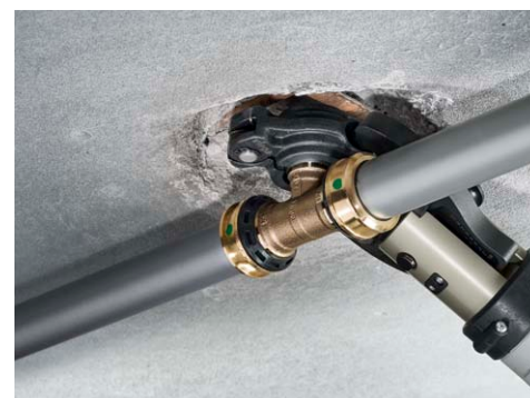
Preprosta in hitra obdelava: namestitev je zaradi zgbnih vlečnih čeljusti Viega enostavna tudi na težko dostopnih mestih
